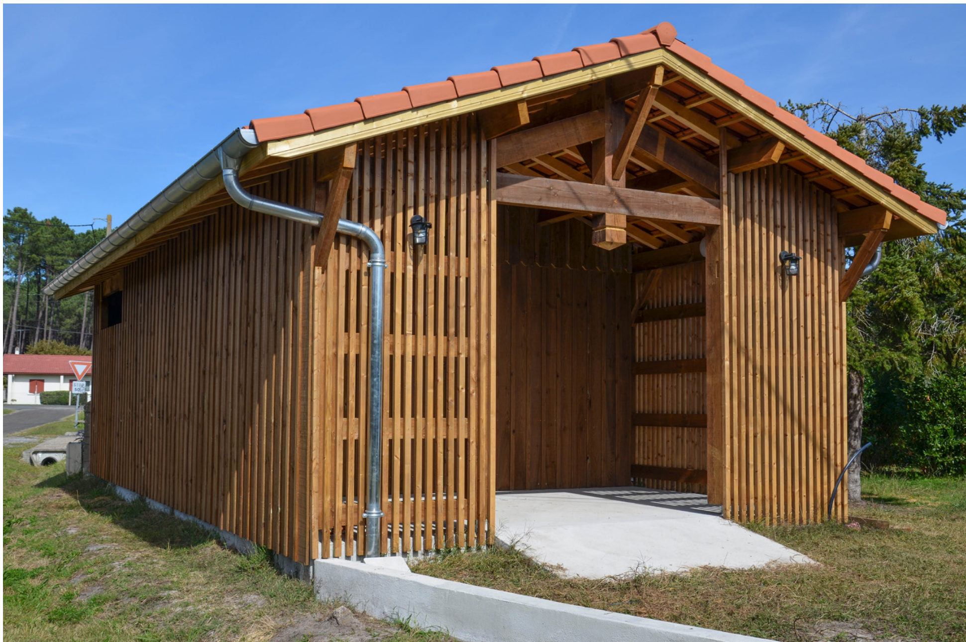
Photos du chantier © Alizée Cugney / Dorodango Architecture
