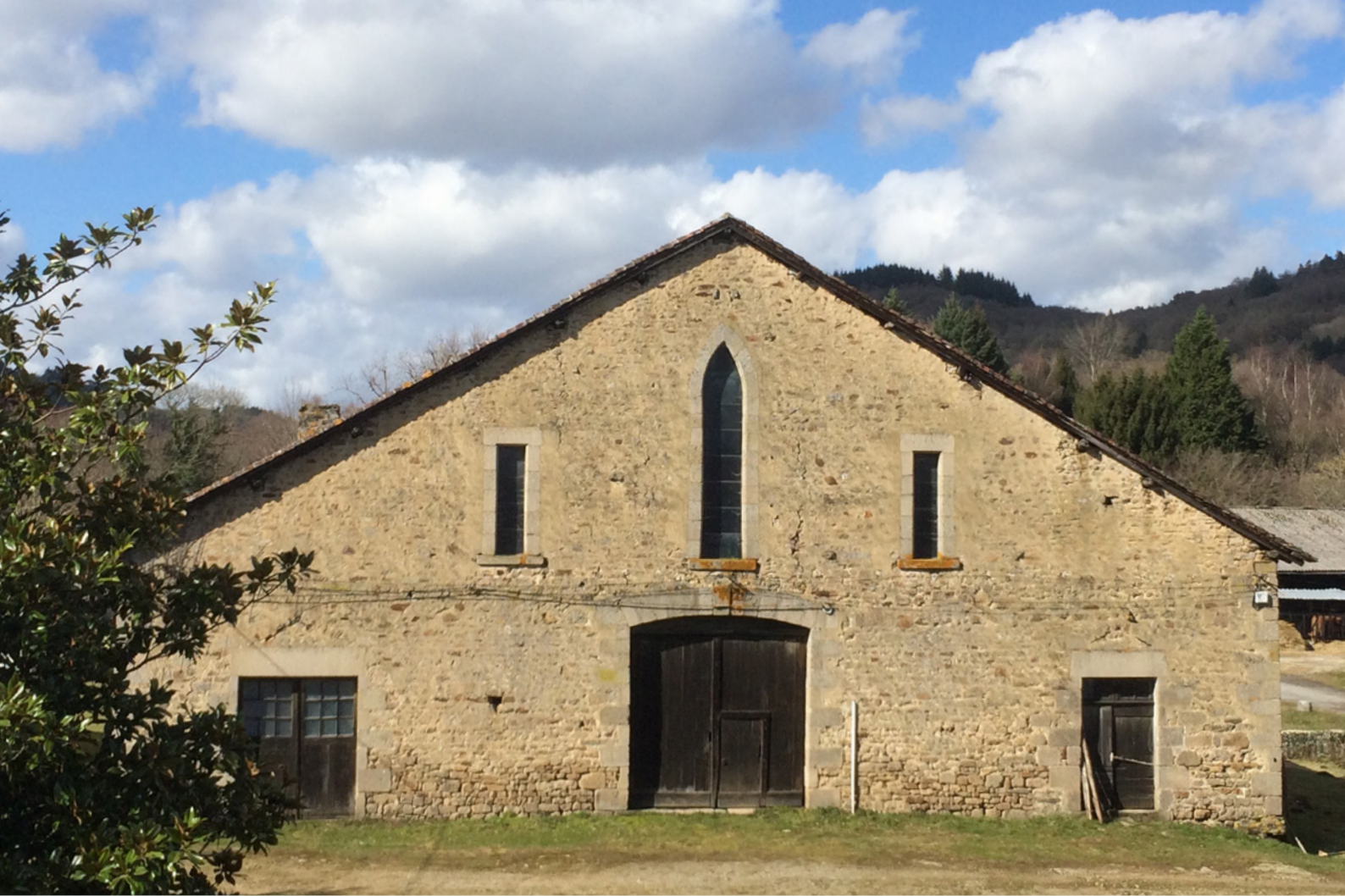
Grange aux Moines, façade Sud-Est ©Association de la Grange aux Moines
