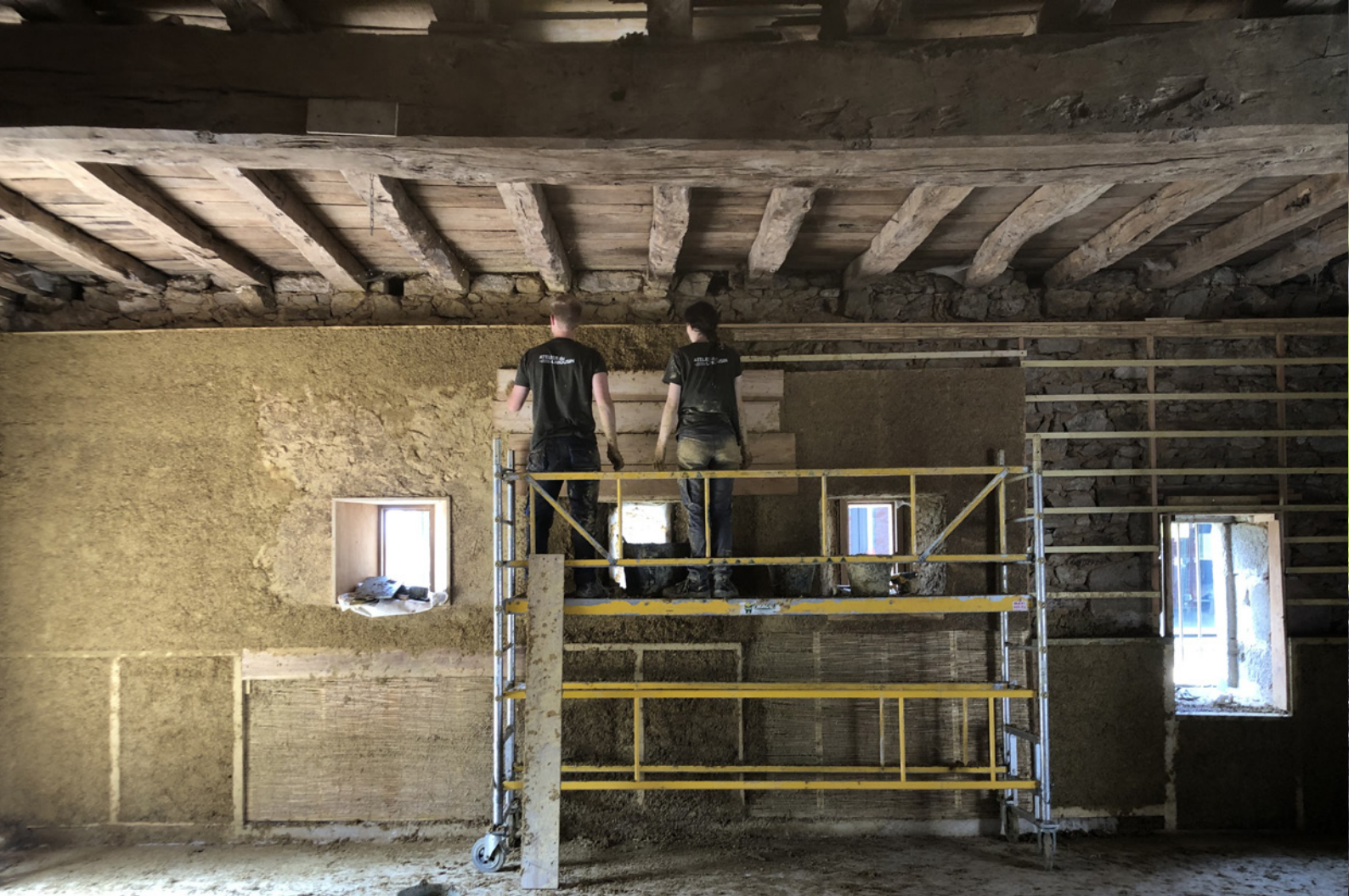
Grange réhabilitée, isolation thermique terre-chaux. ©Paul-Emmanuel Loiret/ Atelier du Limousin. Une des réalisations 2022-2023 à Bellac
