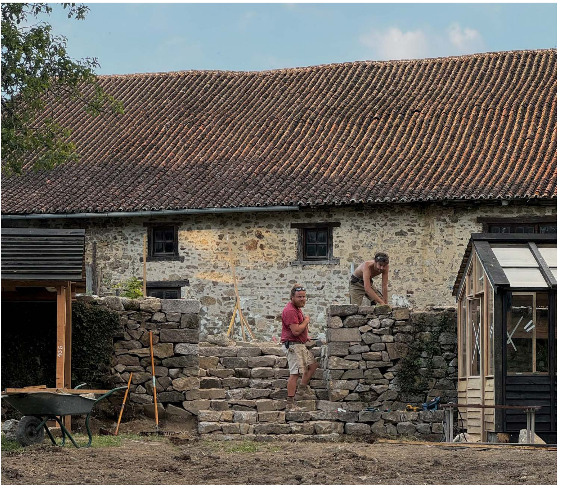
Pose des dernières pierres
