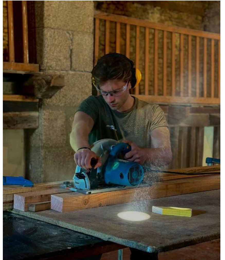
Prefabrication des menuiseries extérieures
