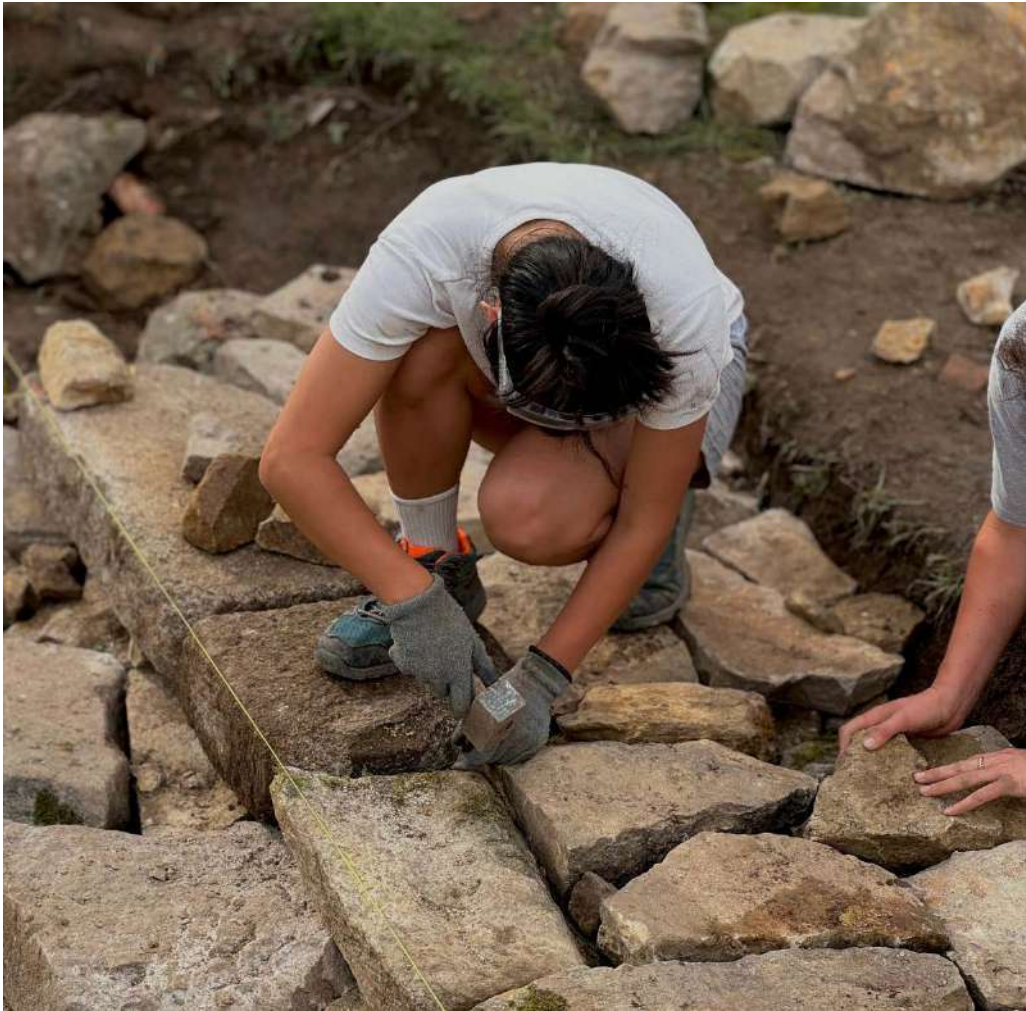
Pose des pierres
