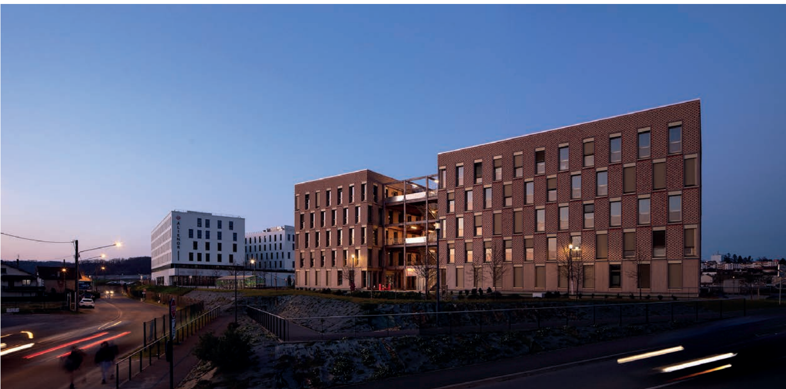
O4 - La maison Départementale de l'Habitat, baptisé L'oustal, s'intègre dans le nouveau quartier d'affaires de Périgueux. photo ©Edouard Decam
