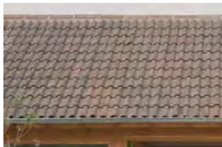
Toitures tuiles canals
