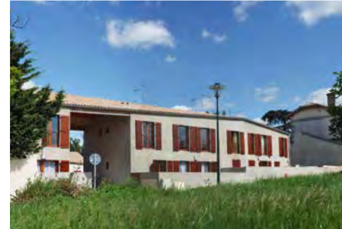
11 Logements individuels Sainte-Eulalie_La Nouvelle Agence
