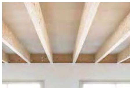
Plafond mixte bois-béton
