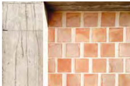
Structure béton et remplissage terre cuite
