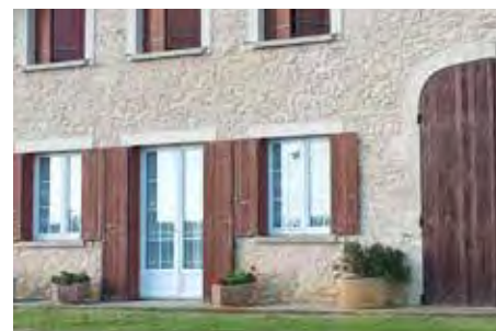
Menuiseries extérieures et occultations bois
