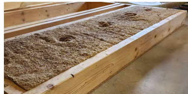
Mise en œuvre en atelier
