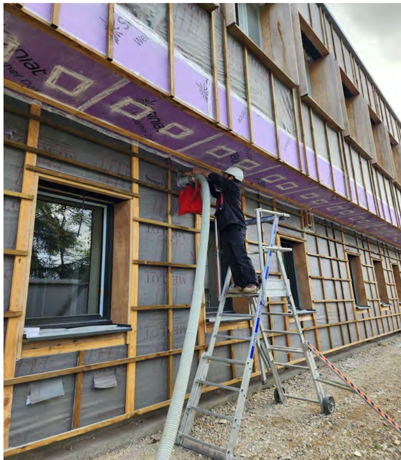
Insufflation sur chantier
