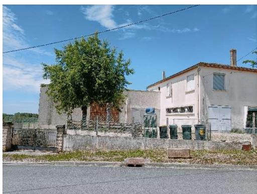
Vue de la façade S.O côté bourg
